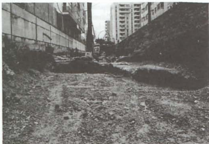
LAM. IV. Estructuras hidráulicas en el antiguo cauce de la rambla de Belén.
