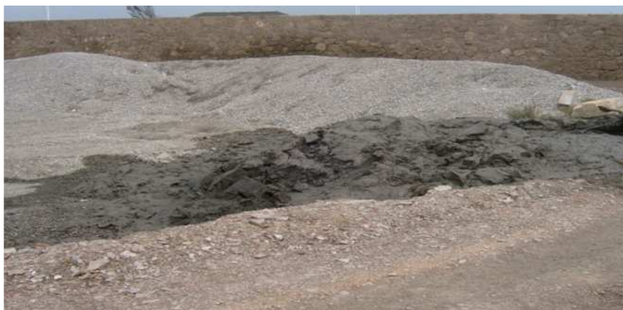
Lámina II: vertido del material en la playa artificial
