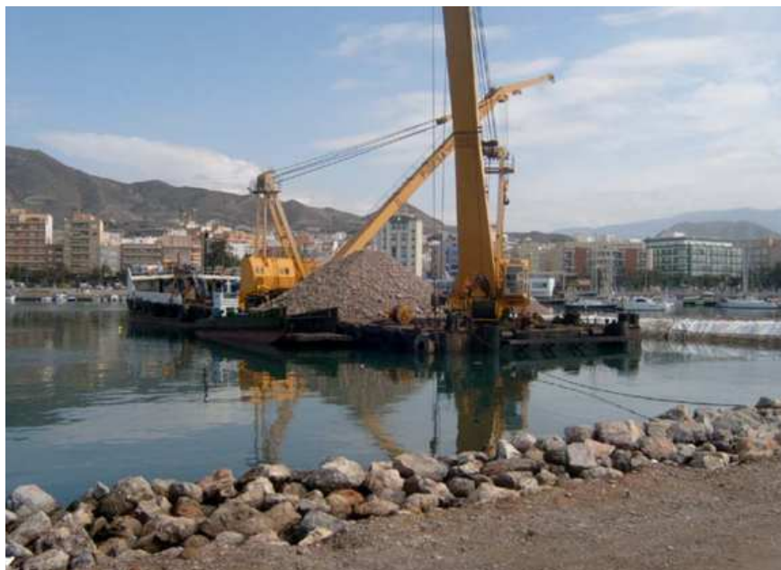
Lámina I: pontona en la zona de dragado del nuevo pantalán
