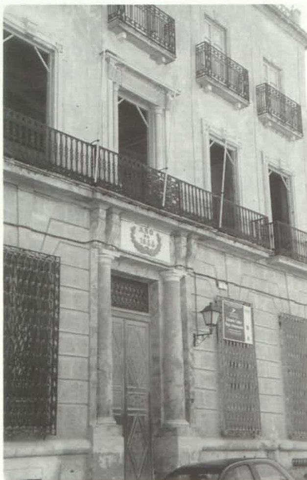
Fachada en la actualidad del edificio en el que se ubicó el Instituto de 2ª Enseñanza de Cuevas del Almanzora.
