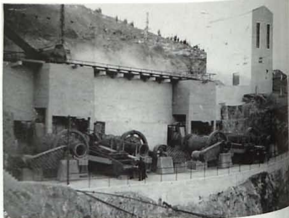
Figura 21. Zona de molienda en húmedo (Fernández Espinar, 1958).
