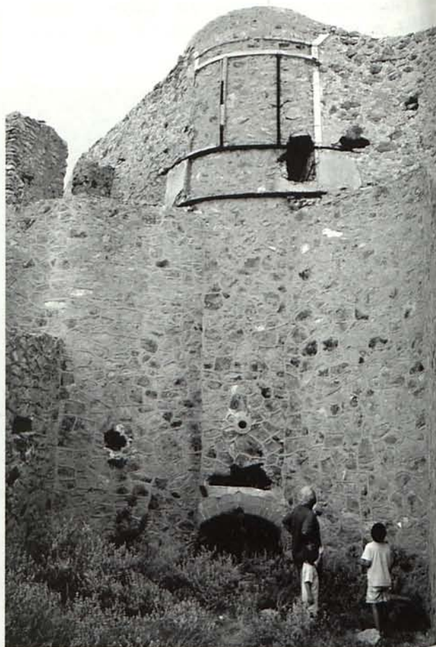
Figura 10. Horno de cuba en donde, al parecer, se caldeaba el mineral antes de su trituración.
