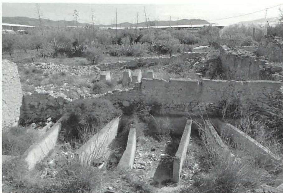
Figura 25. Bancadas y canales de la instalación.
