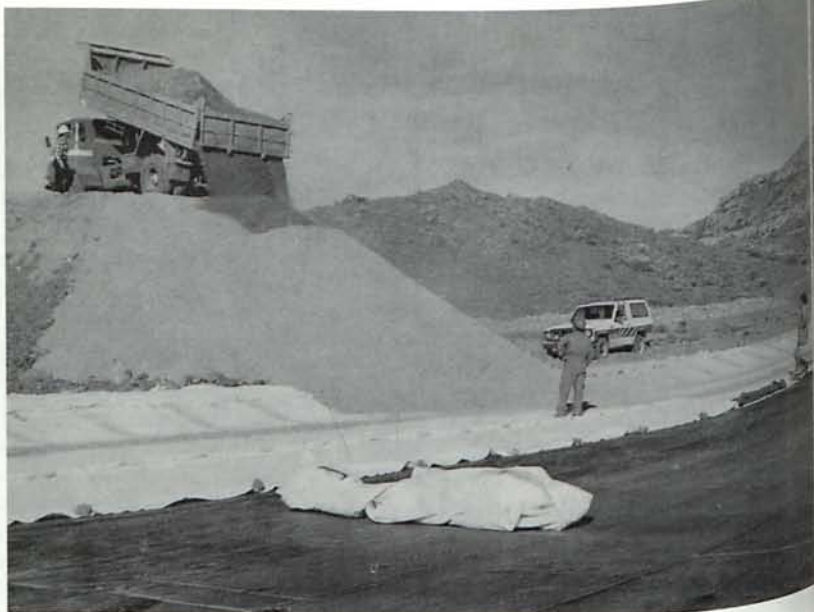
Figura 27. Proceso de creación de una pila de mineral para lixiviar (ITGE, 1991).
