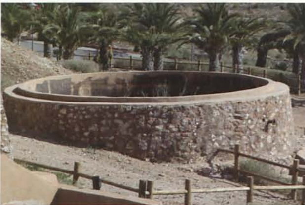
6. Tanque de piedra de la Planta Dorr (1930)
