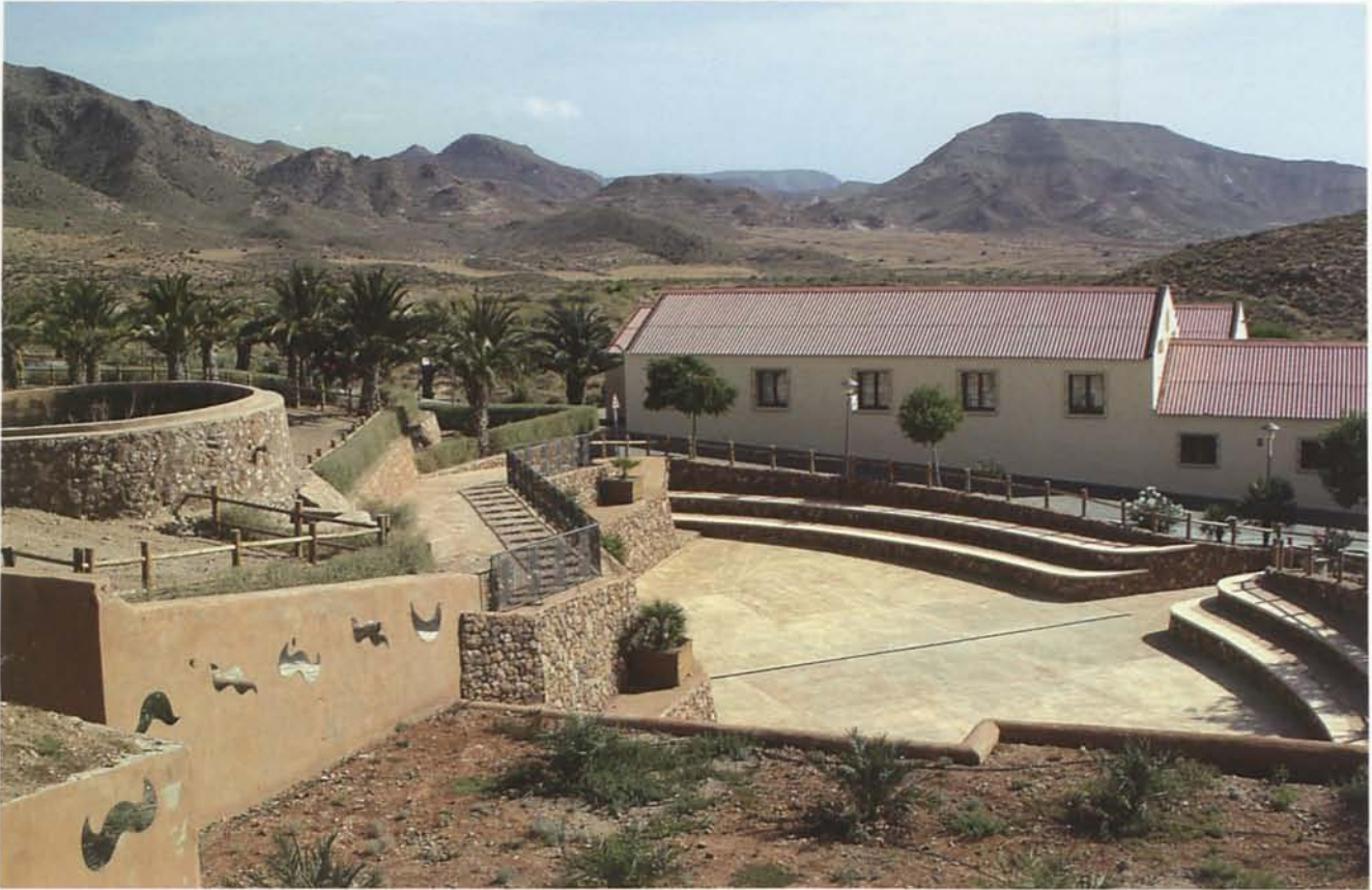
5. Lugar en donde se emplazaba la Planta Dorr: instalación metalúrgica aurífera de cianuración de Minas de Rodalquilar S.A. (1930)
