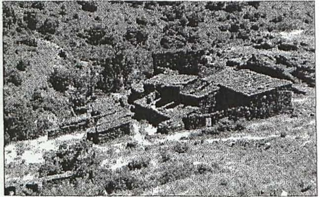
FIG. 4. Cortijada abandonada con cubierta y muro de esquistos.
