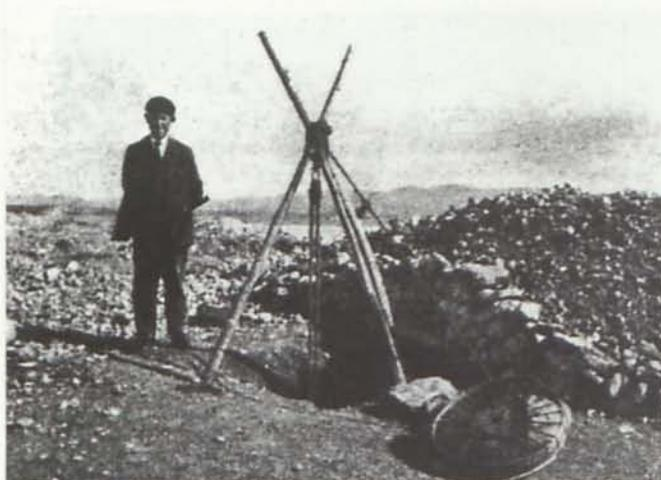
Foto 18. Pocillo de investigación-explotación con un mecanismo de extracción tan sencillo y primitivo como el trípode para sostener la cuerda que subía y bajaba los canastos de esparto con el mineral. (Wegner, 1933)
