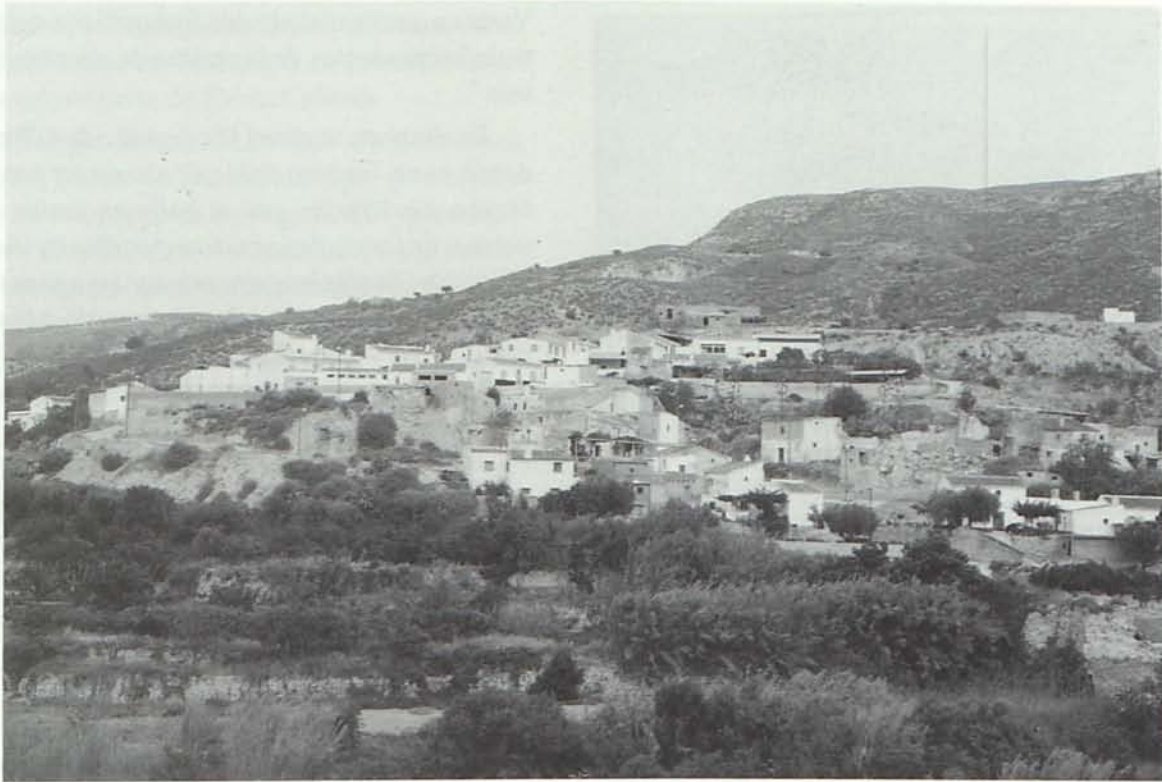
Vista del caserío de La Herrería, desde el acceso nuevo a la autovía
