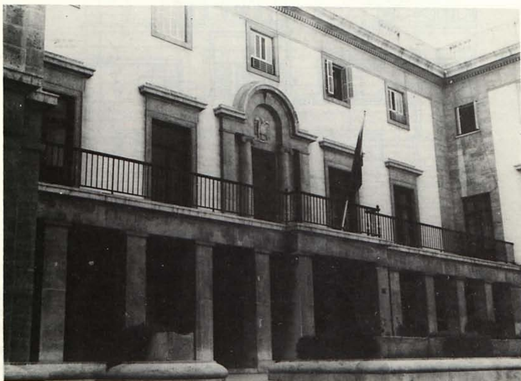
Fig. 3.- Detalle de la fachada principal
