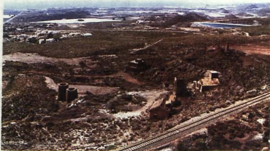
Figura 3.- Instalaciones mineras: hornos de tostación del mineral de hierro. Al fondo el mar.
