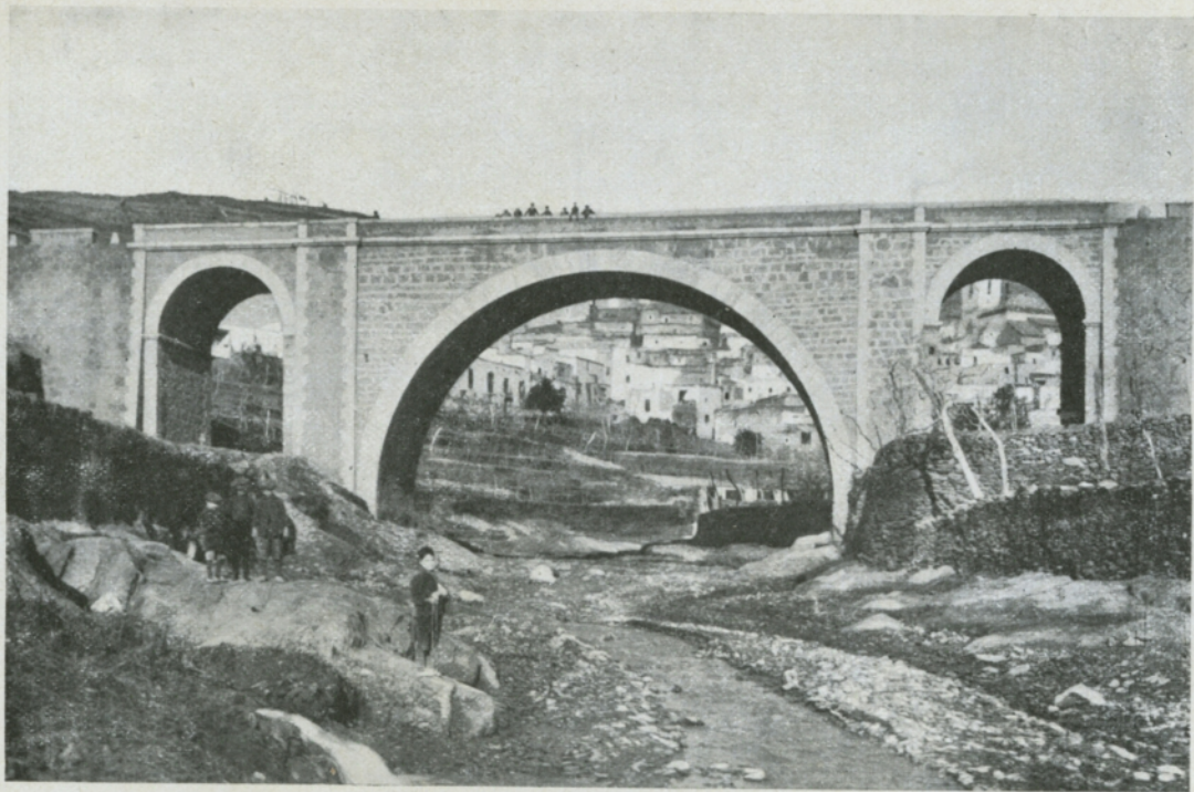
Sobre una rambla que vierte al río Almería, se tiende el puente por donde pasa la carretera de Tabernas.
