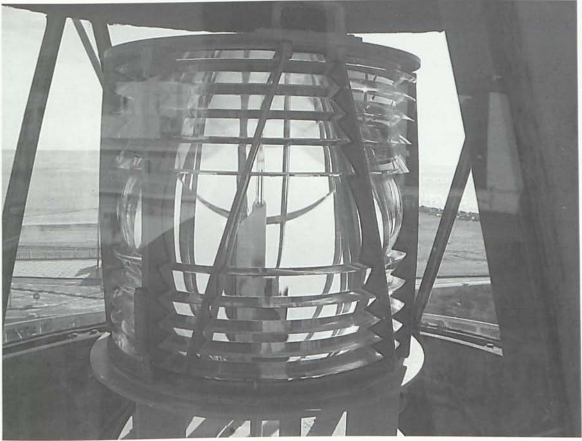
Óptica de tambor del Faro de Garrucha. (Foto del autor)
