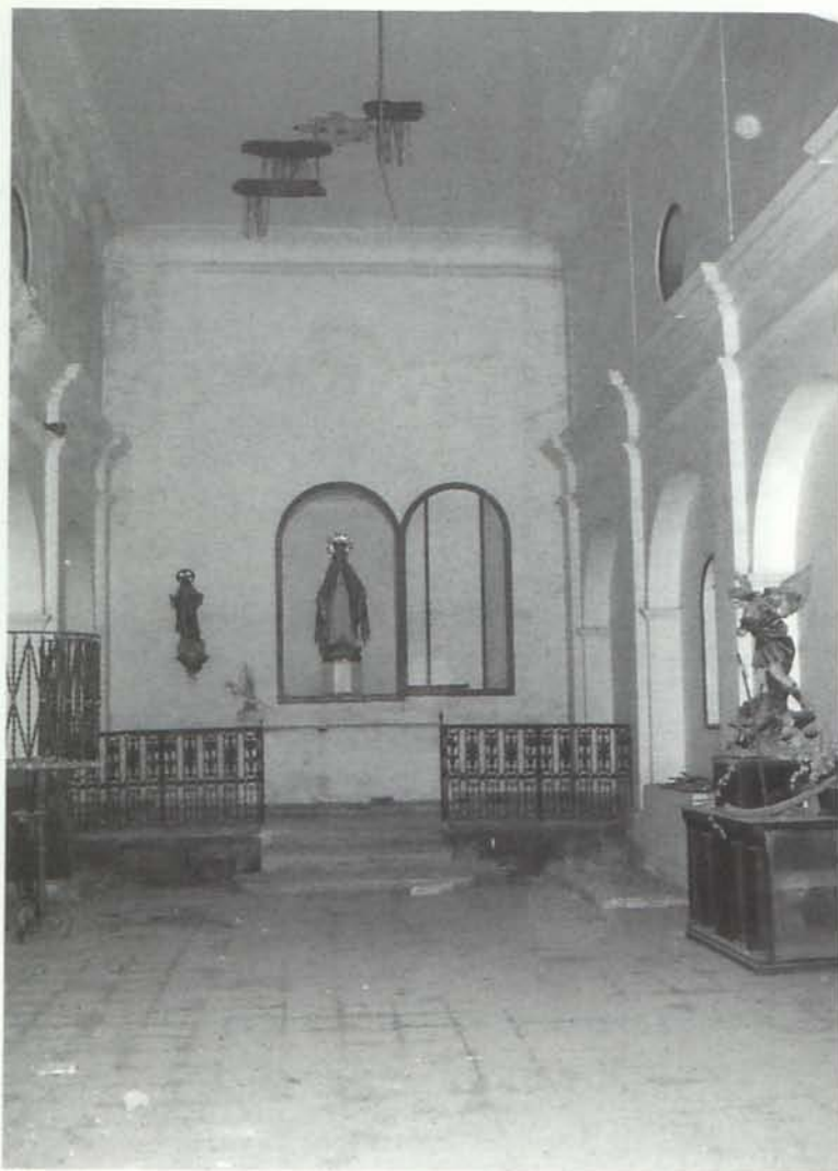
Interior de la ermita de San Antón, en la actualidad, con algunas imágenes religiosas, que aún perduran. Ha sido cedida gratuitamente por la familia Giménez al Ayuntamiento para su rehabilitación. (Col. del autor)
