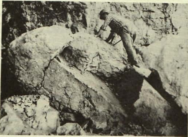
LAM. IV. Fotografía en la que se aprecia uno de los grandes bloques de piedra, en el momento que se empieza a desmontar para sacarlo piedra a piedra.
