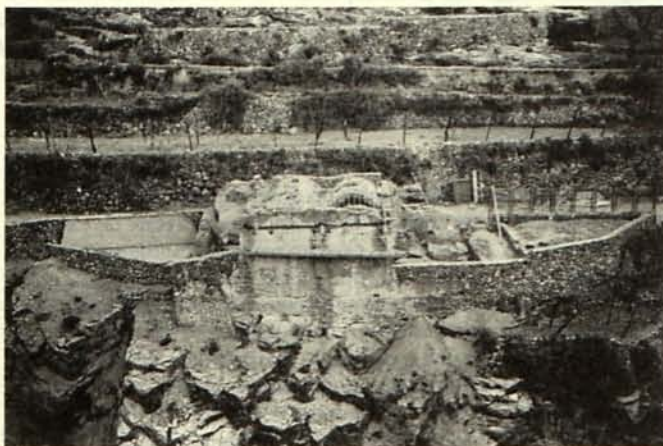
LAM. 1. Vista del exterior de los Baños durante su restauración y excavación.
