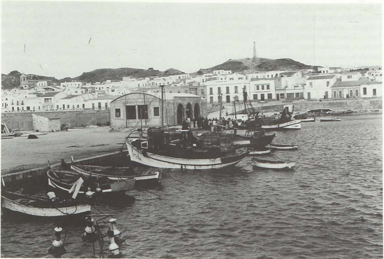
7. La Pescadería, durante su construcción.
