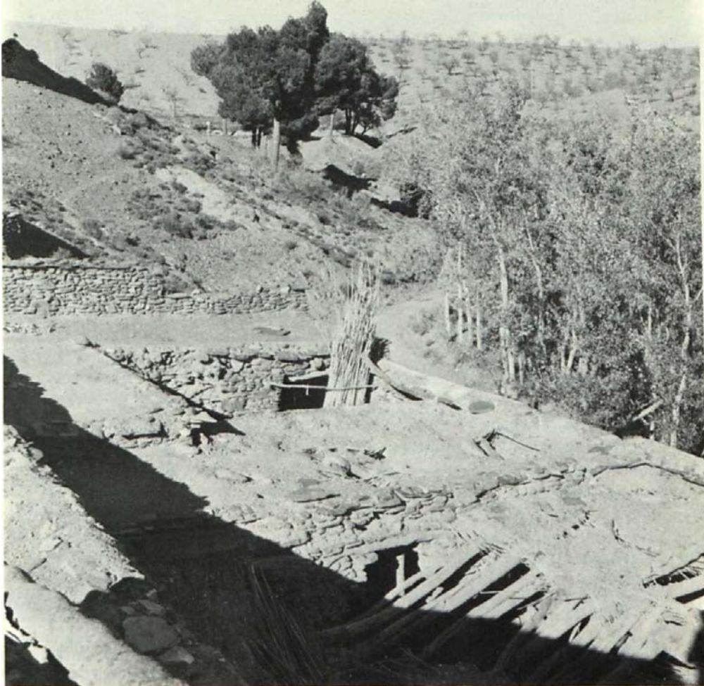
Pl. VIII.—Structure d'un terrado .—L'effondrement de la couverture de ce cortijo proche de Fihana permet de voir les éléments constitutifs de celle-ci: poutrage serré de troncs de peupliers, nappage de roseaux et couche de terre.
