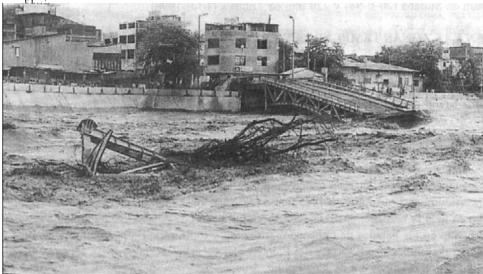
FIGURA IV. En Piura, el tradicional «Puente Viejo» fue arrastrado el 12/marzo/1998, por la crecida del río Piura que alcanzó un caudal histórico de 4.424 metros cúbicos por segundo. (El Comercio, Urna, 15/III/marzo/1998).
