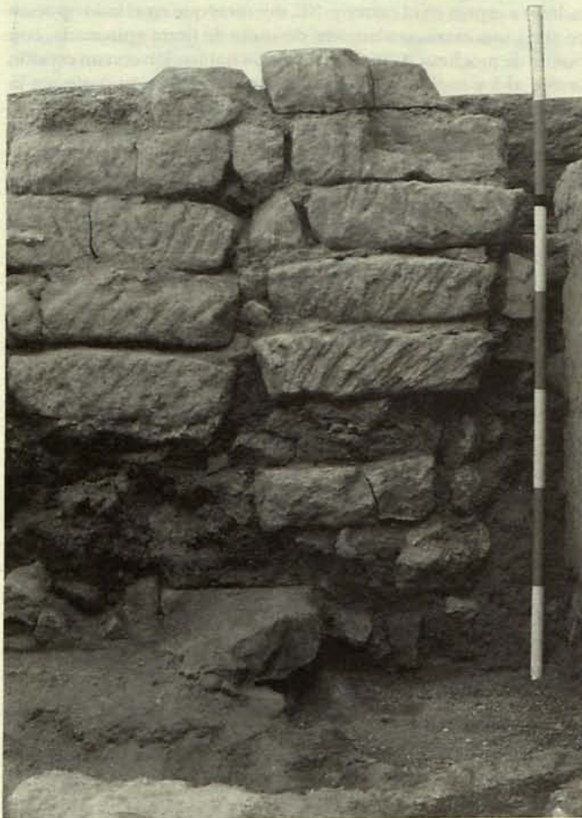
LAM. 5. Muro de sillares de arenisca (corte 3).
