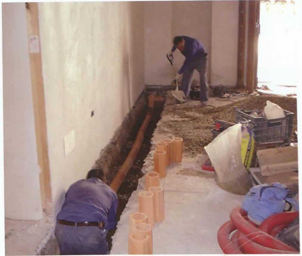
Zanja perimetral para eliminar las humedades.
