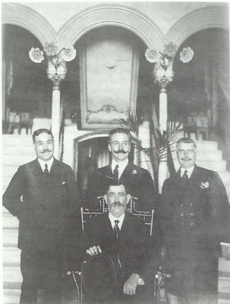
Imagen paradigmática que representa a los hombres fuertes de la comarca en las fechas inmediatas al golpe de Estado de Primo de Rivera. A la izquierda don Simón Fuentes, de Garrucha; en el centro, de pie, Augusto Barcia Trellez, diputado por el Distrito de Vera; a la derecha, Francisco Ferrer Galindo, de Vera; sentado, don Pío Fernández, de Albox. (Foto. col. Juan Grima).
