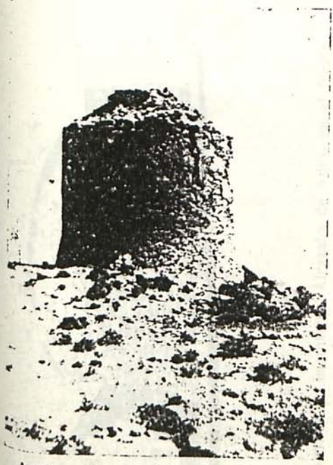
Antigua torre vigía de Alhamilla. Fachada oriental. Enlaza con el fuerte de Guardias viejas.
