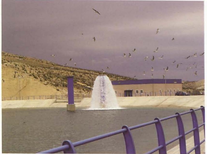
2. Entrada de agua producto a la balsa de impulsión. (Col. del autor)
