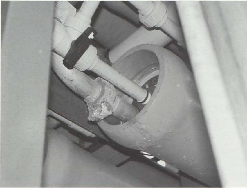
9. Salida de agua producto y salmuera de membranas. (Col. del autor)
