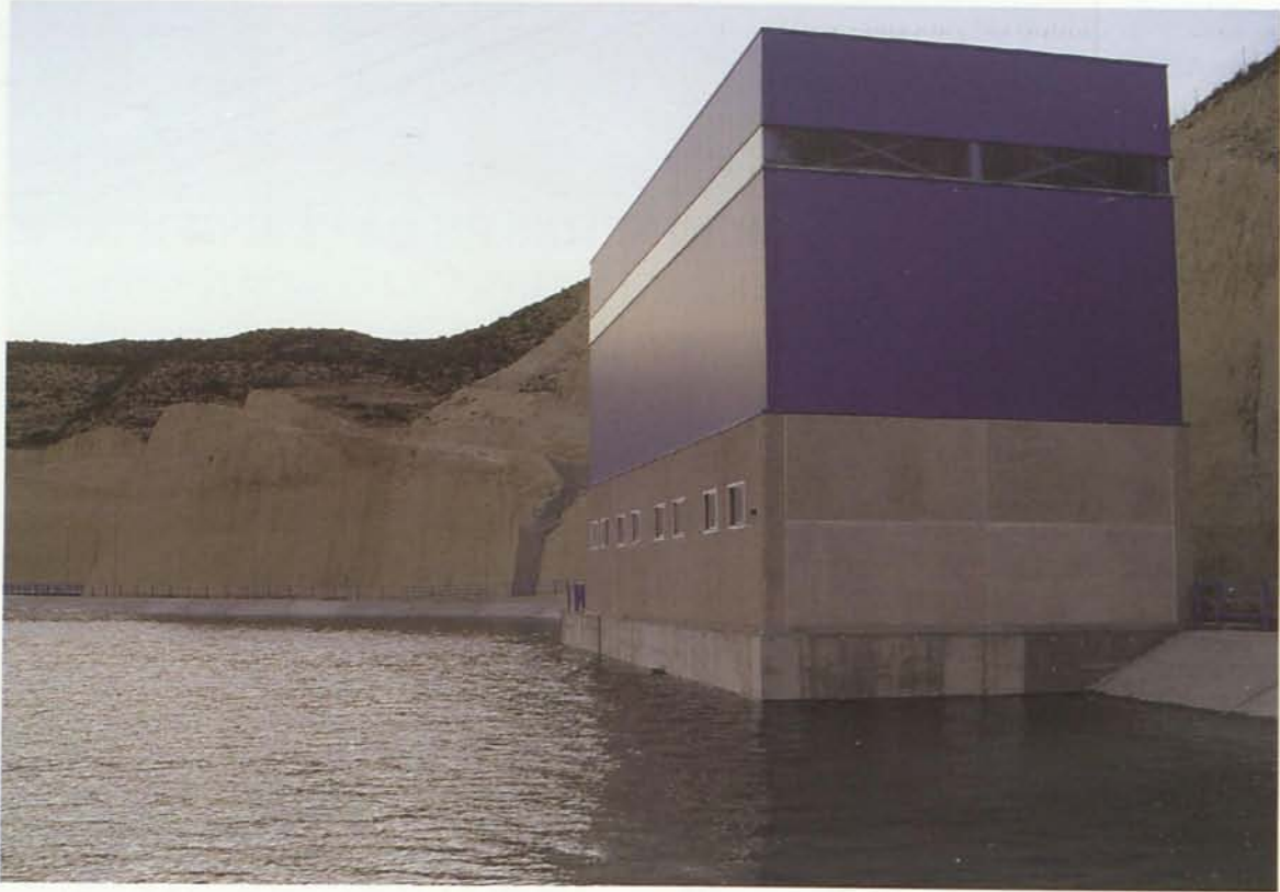
1. Caseta de bombas de impulsión. (Col. del autor)
