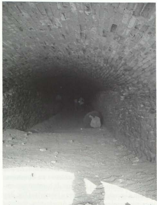
Fig. 3. Antigua galería de transporte (socavón Santa Bárbara) construido por Minas de Almagrera S.A. (MASA)
