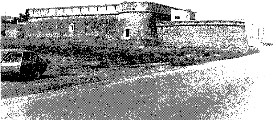
Castillo de Garrucha: De forma cuadrangular con una batería semicircular adosada mirando al mar; este tipo de castillos con algunas variantes se repiten con frecuencia.
