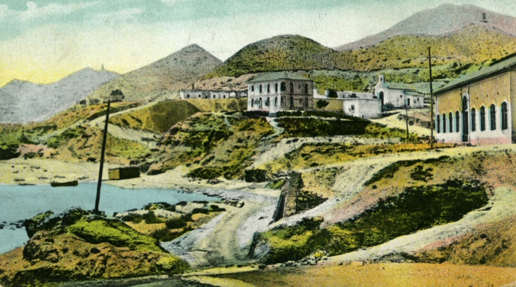
Instalaciones de la S. Argentifera - Villaricos.
