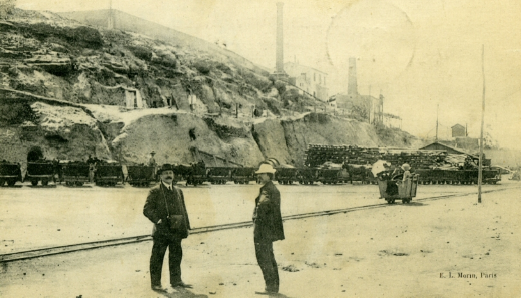
Société Minière d'Almagrera. — Mine Puerto Rico. — Installation d'épuisement, Dépôt de Bois
