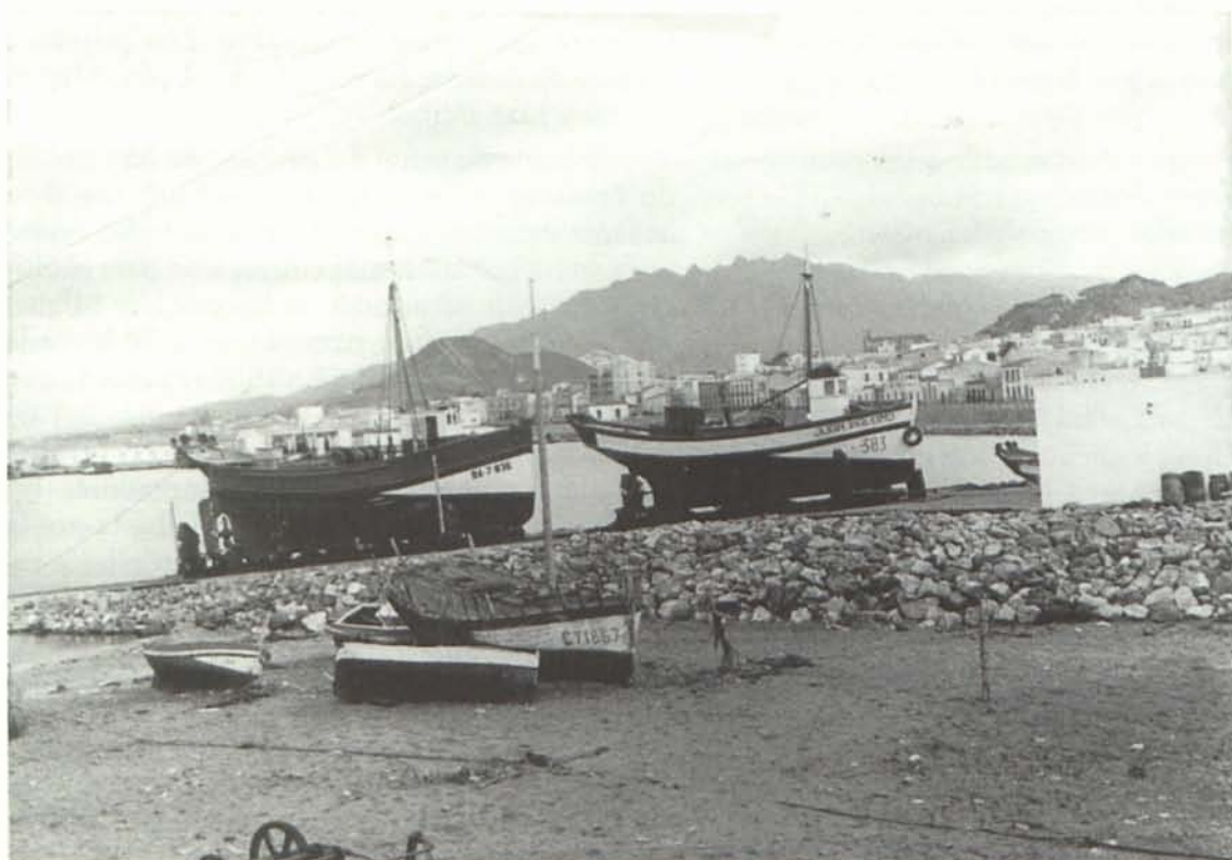
El varadero de Garrucha, recién construido.
