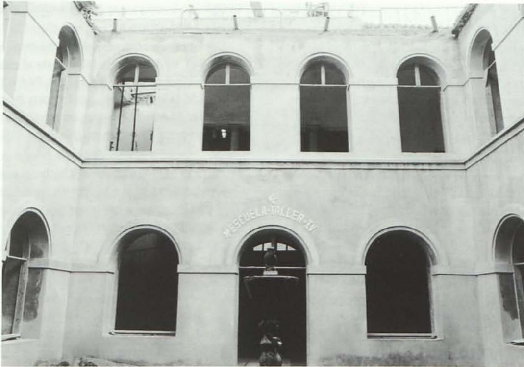
3. Claustro del Convento tras la intervención de una de las Escuelas-Taller (Foto del autor).
