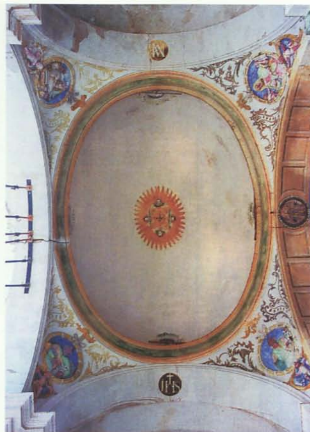
Fig. 13: Cúpula del crucero el año 2000, antes de su restauración
