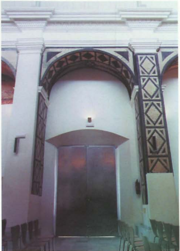
Fig. 51: Puerta lateral de la iglesia del convento de Mínimos, año 2004, tras su restauración
