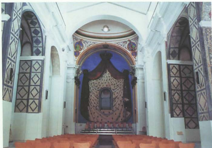
Fig. 10: Nave de la iglesia de los Mínimos hacia la capilla mayor restaurada el año 2003
