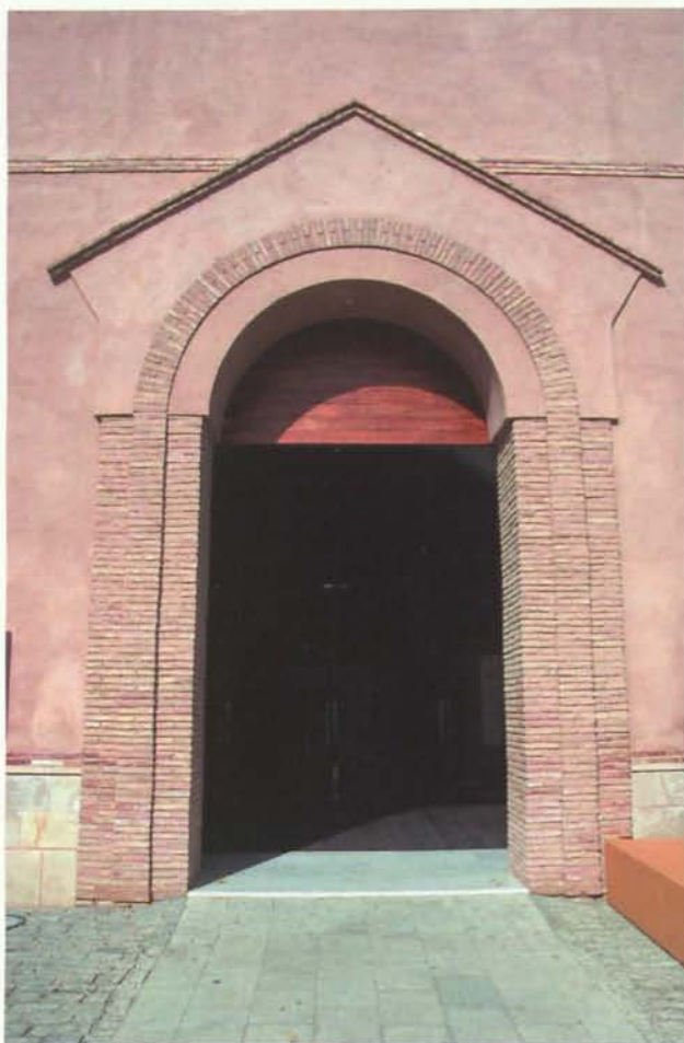
Fig. 4: Puerta de entrada a la iglesia del Convento de Mínimos restaurada, 2005
