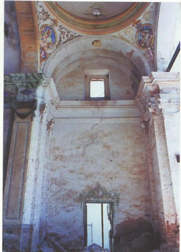
Fig. 17: Testero de la Epístola en el crucero, con puerta de acceso a la sacristía, el año 2000
