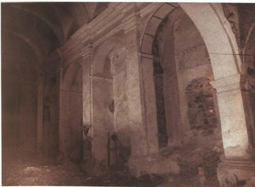
Fig. 22: Capillas del lado de la Epístola de la iglesia del convento de la Victoria de Vera, hacia 1985. AMV: Leg. 757, s. n.
