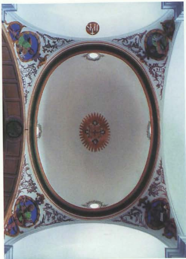
Fig. 14: Cúpula del crucero restaurada, año 2003
