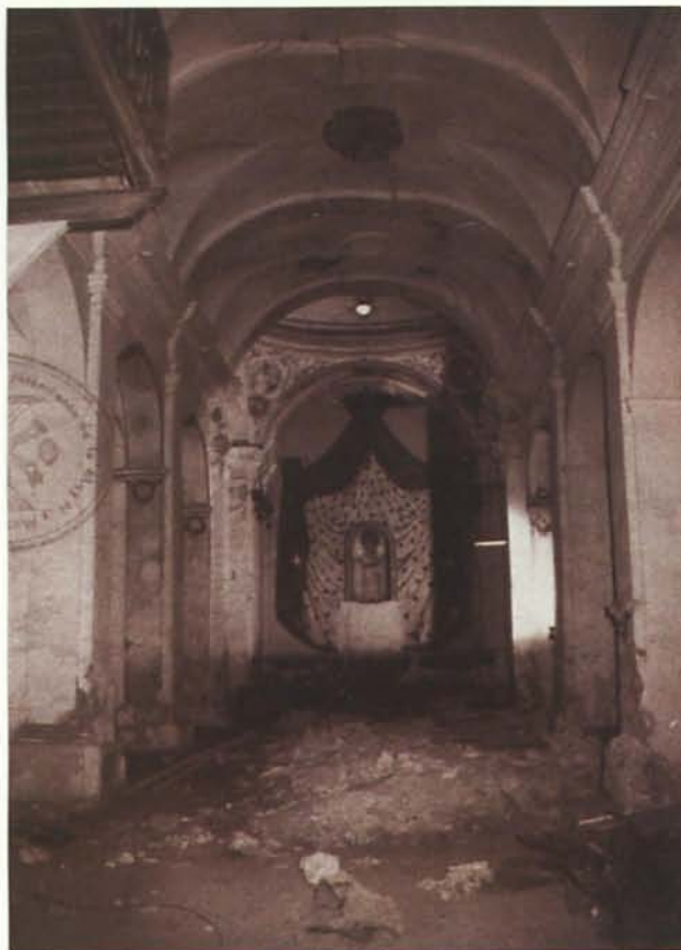
Fig. 5: Iglesia del Convento de Mínimos de Vera, desde la entrada, hacia 1985. AMV: Leg. 757, s. n.
