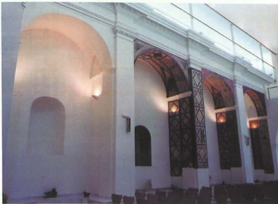
Fig. 23: Capillas del lado de la Epístola de la iglesia del convento de la Victoria de Vera tras su restauración, en 2004
