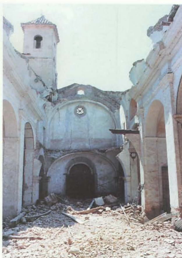
Fig. 9: Nave de la iglesia de los Mínimos hacia los pies el año 2000, tras la demolición de su bóveda.
