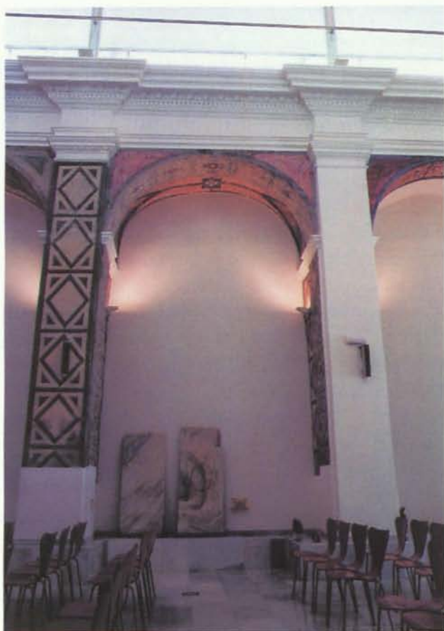
Fig. 28: Capilla tercera de la Epístola, en el año 2004, tras su restauración
