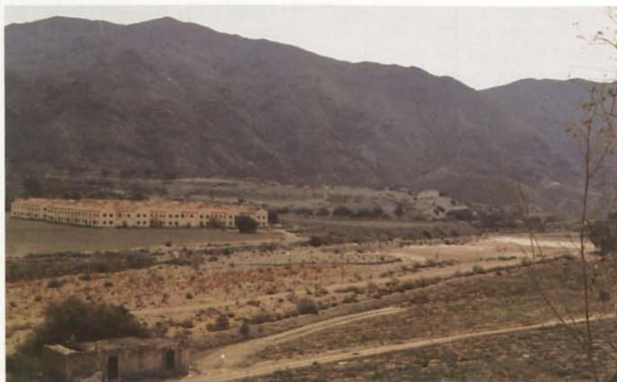
Fig. 1. Lodos de flotación y antiguo poblado minero en la zona del Arteal (Sierra Almagrera).
