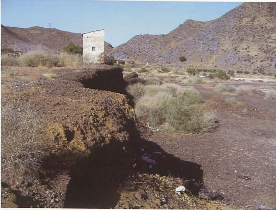
Fig. 8.- Vista de un depósito de escorias alteradas por la meteorización en las faldas de Sierra Almagrera
