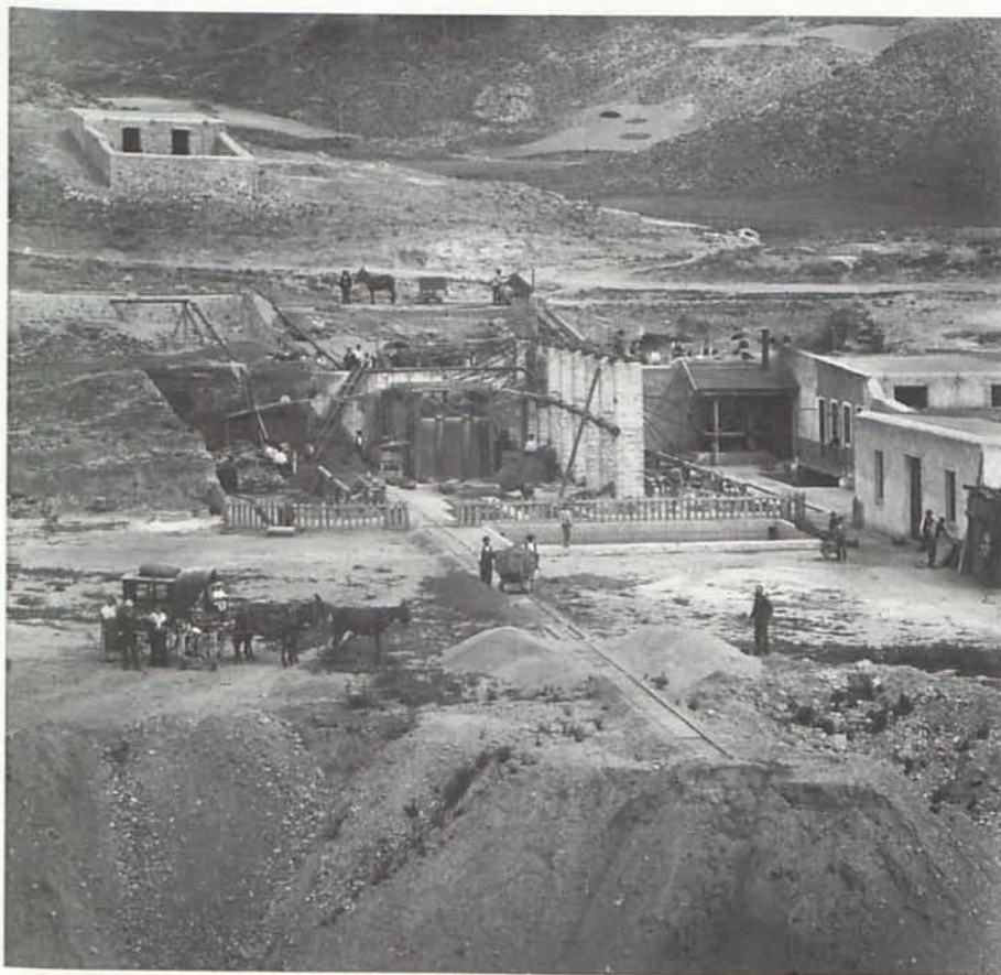
6. En la mina Reforma de Bédar trabajaban varias decenas de obreros en el exterior limpiando y lavando el mineral. El desarrollo de estas actividades contribuía al posible padecimiento del cólico saturnino. En el caso de Bédar, entre 1880 y 1900 se contabilizaron hasta 18 casos de cólico con resultado de muerte. Hacia 1875. (Foto de José Rodrigo / Fondo Cultural Espín de Lorca)
