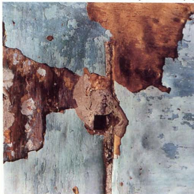
Desconchados en las paredes. (Foto: P. Siquier)
