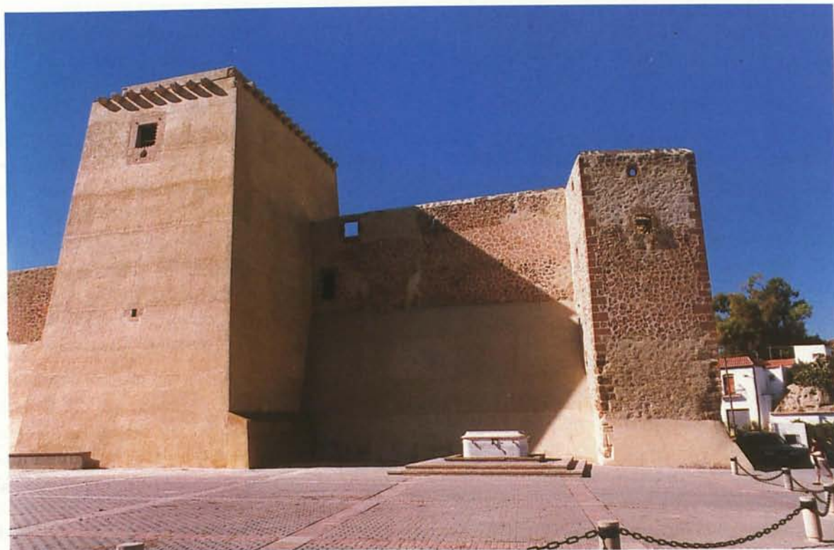
Torre del Homenaje y murallas, rehabilitación financiada por la Consejería de Cultura de la Junta de Andalucía. (Foto de Antonia Giménez)
