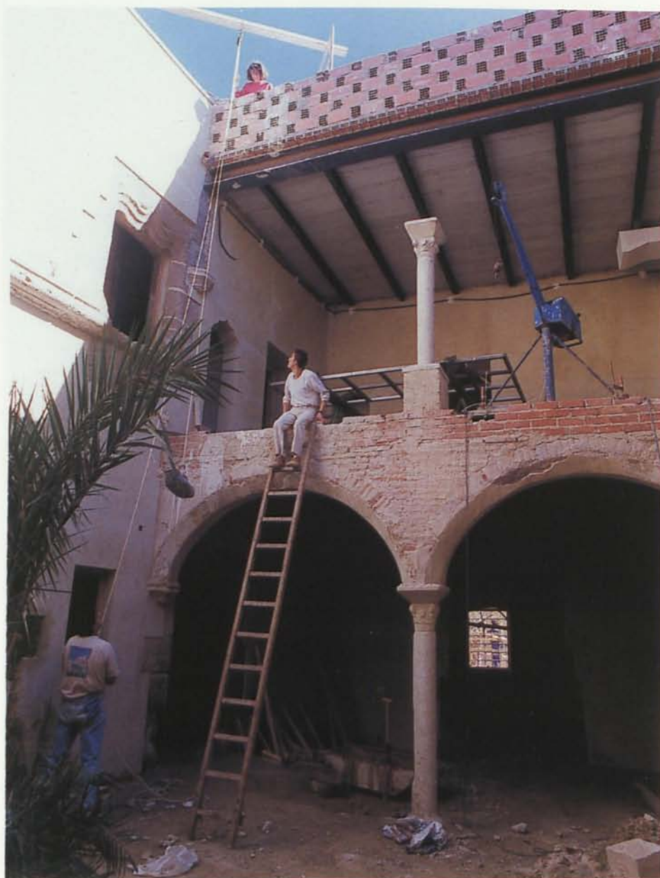
Trabajos de rehabilitación realizados por la Escuela-Taller Bajo Almanzora en el patio del Palacio del Marqués de los Vélez. (Foto de Antonia Giménez)
