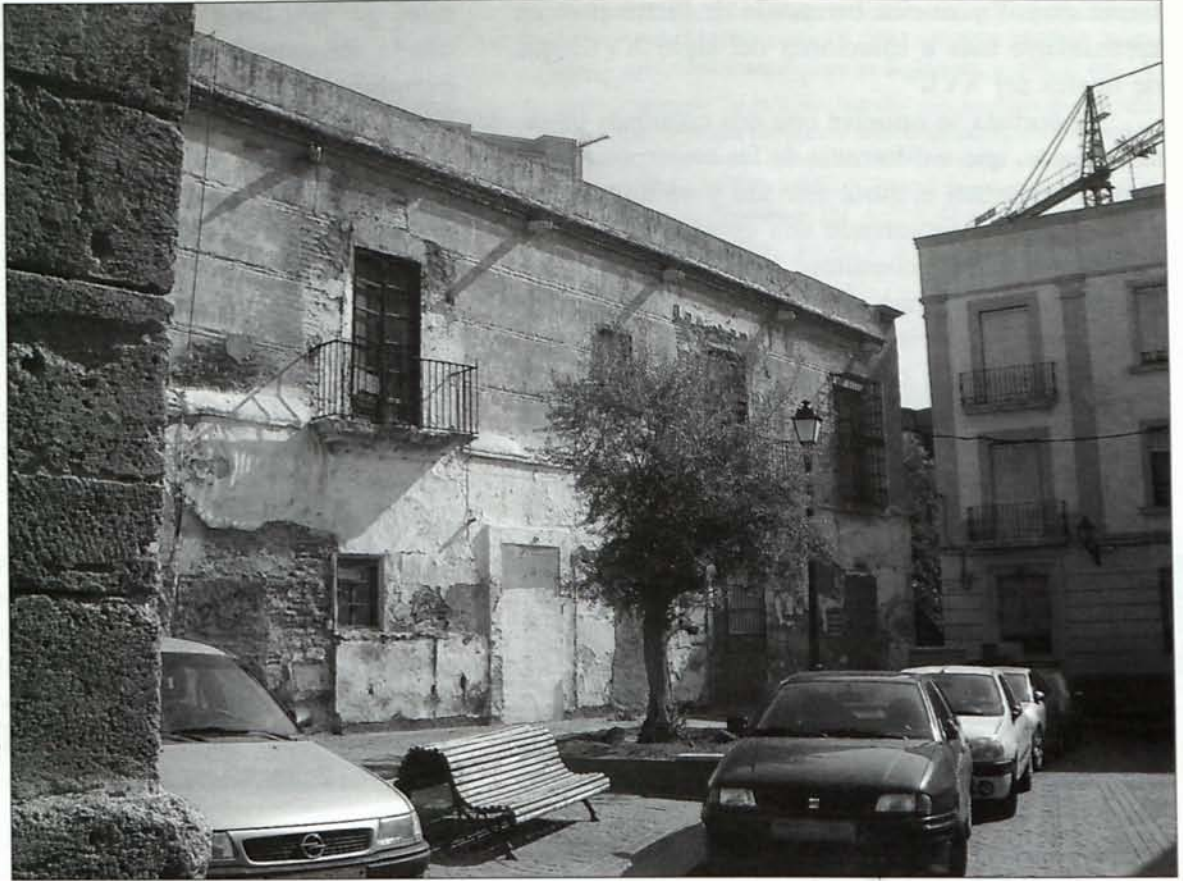
Fachada lateral. (Plaza Jesús Cautivo de Medinaceli).
