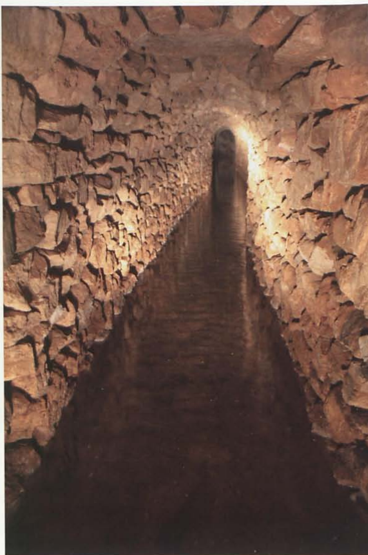
Conducción subterránea de agua de la fuente Asunción
