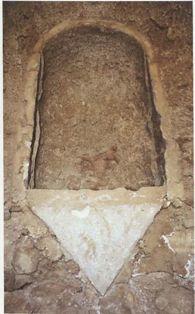
Hornacina a la entrada de las galerías
