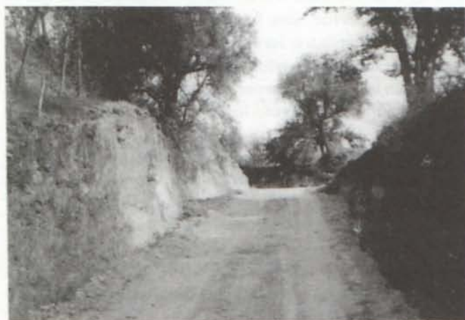
LÁM. 1. Vista general del desmonte del terreno dispuesto para el camino.
