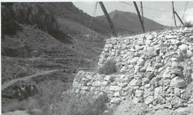
Este balate en dos escalones soporta una gran masa de tierra para parral, como ponen de manifiesto los restos del emparrado.
