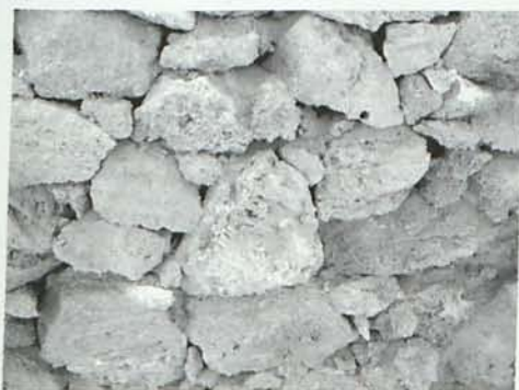
Piezas de toba aportan una particular textura a este balate.
