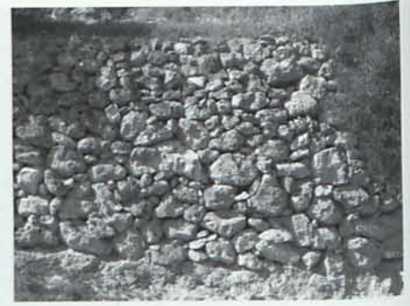
Textura, coloración y tamaño característico de un balate de piezas calizas. El orden constructivo evidencia un recrecimiento del muro.
