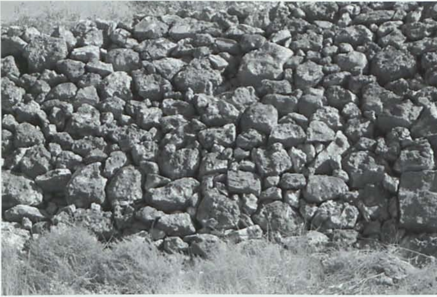
Textura, coloración y tamaño característico de un balate de piezas calizas. El orden constructivo evidencia un recrecimiento del muro.
