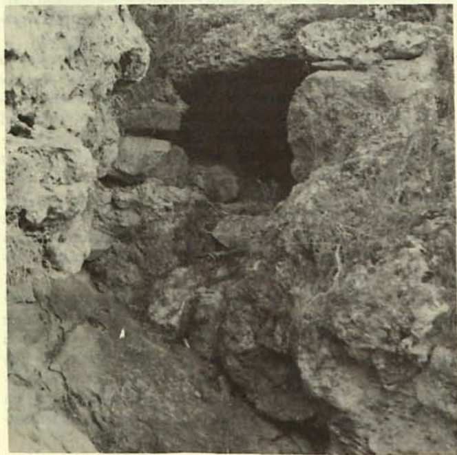
LAM. IV. 2. Estado actual de la segunda galería.
