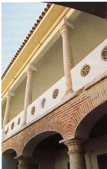
Claustro del convento de la Purísima Concepción. Aparejo de ladrillo pintado sobre el real.
