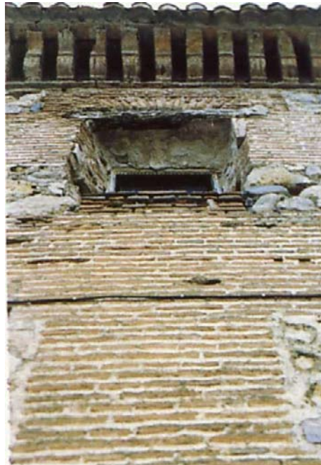
Iglesia parroquial de Benedd. Detalle del aparejo de ladrillo.
