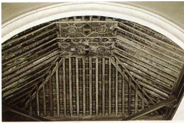
Armadura de limas moamares de la capilla mayor de la iglesia parroquial de Instinción.
