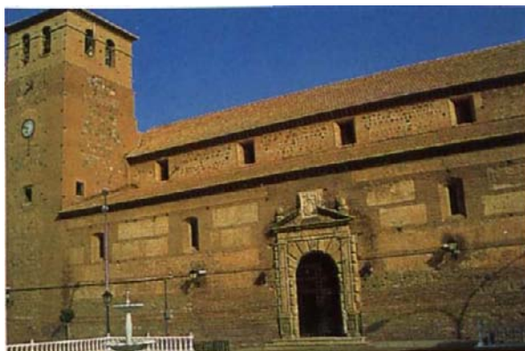
Las posibilidades del aparejo mixto, rafas y cimas de ladrillo y cajones de manpostería. Iglesia parroquial de Taliernas.
