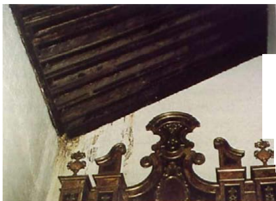
Armadura de colgadizo de una de las naves Laterales de la iglesia parroquial de Fiñana.
