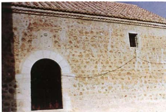
Fachada lateral de la iglesia de Vúcar. Aparejo de manipostería.
