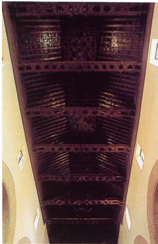
Armadura de la nave central de la iglesia parroquial de Tabernas,
