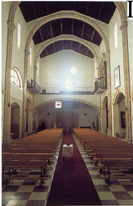
Interior de la iglesia de Santiago de Vélez Blanco. Ejemplo de iglesia con arcos diafragma.
