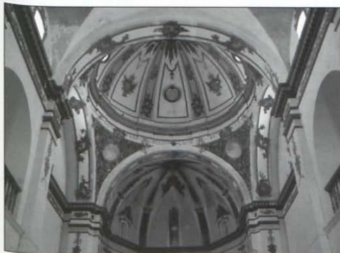
Cúpula de media naranja sobre pechinas y bóveda de la capilla mayor. Los tondos de las pechinas se encontraban desmontados para su restauración
