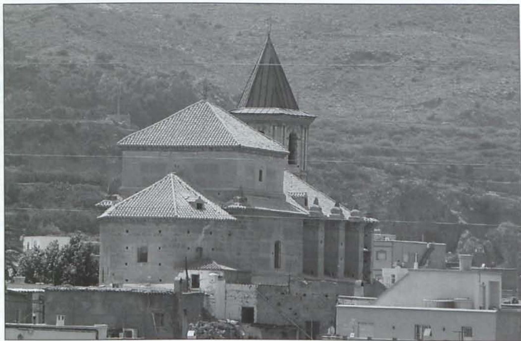
Vista de la iglesia desde la cabecera del edificio.
