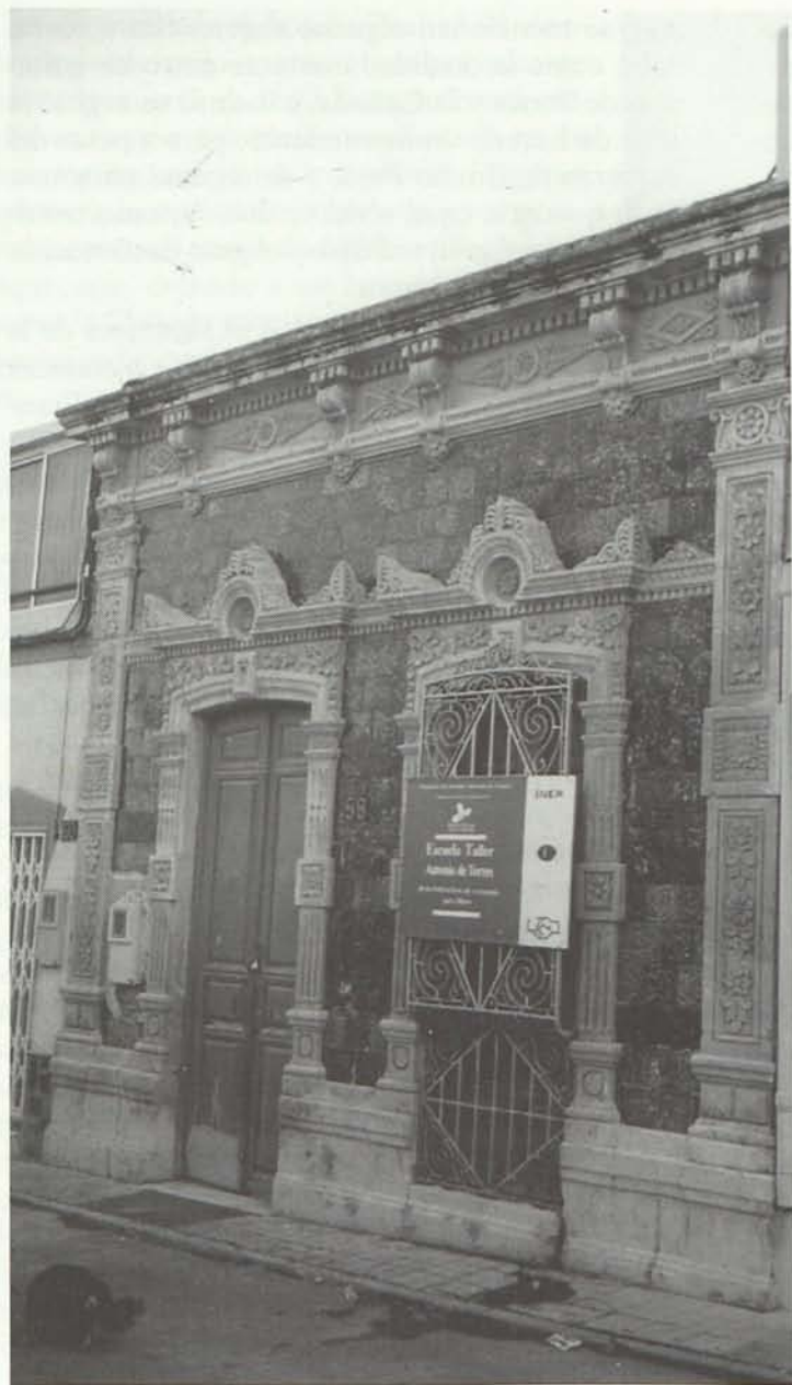
Fachada de la casa de don Antonio de Torres en La Cañada (Almería).
