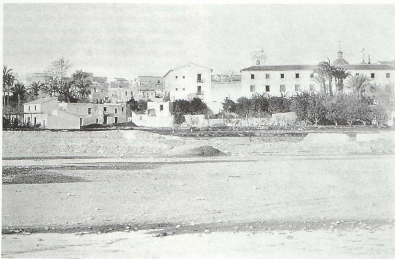
Panorámica parcial de Cuevas, tomada hacia 1908 desde el cauce del río. En primer término, se distinguen los ruinosos y deteriorados muros que poco podían hacer ante las arremetidas periódicas del Almanzora. Fotografía de Federico de Blain Becerra. (Col. Juan Grima)
