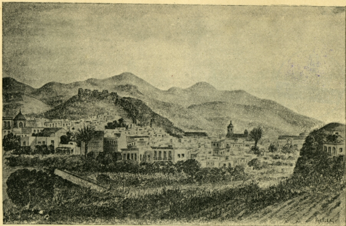
Almería; vista parcial tomada del extremo Oeste del anden de la Estación
