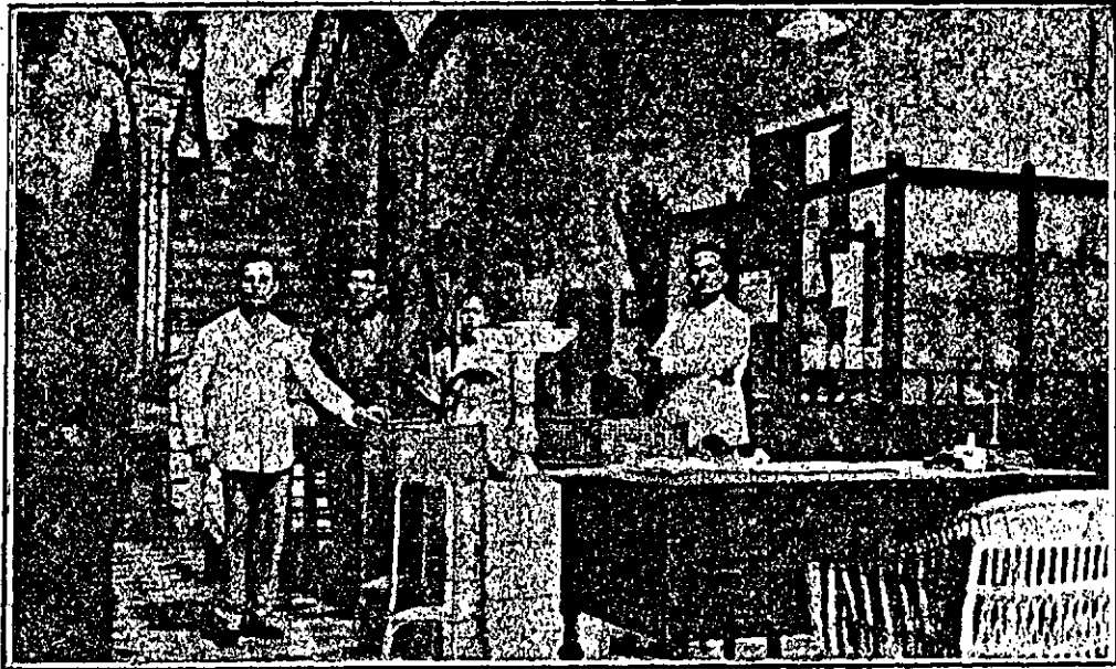
VISTA PARCIAL DEL HOTEL
