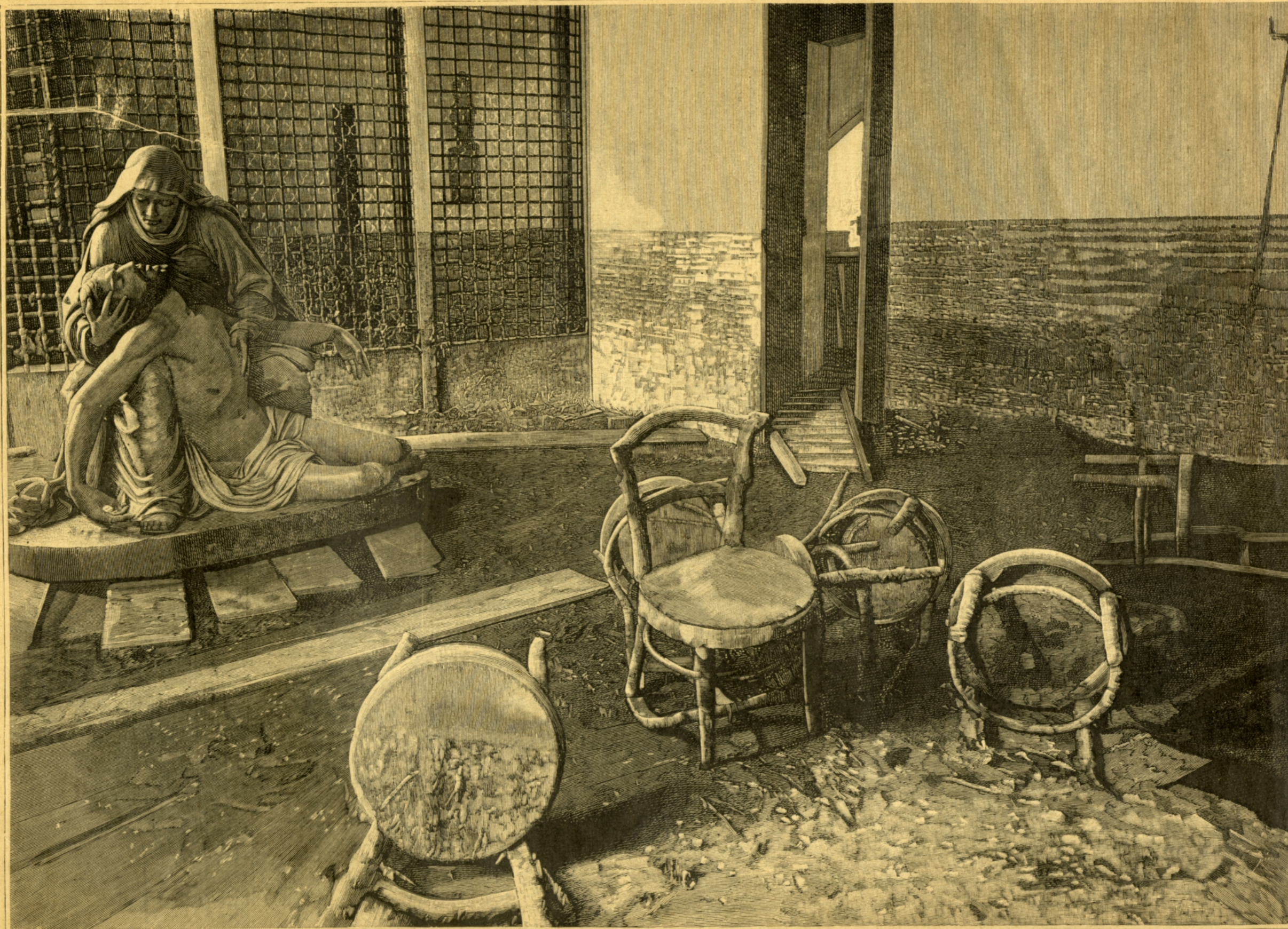
ALMERÍA.—INTERIOR DEL CONVENTO-COLEGIO DEL OBISPO ORBERA, DESPUÉS DE LA INUNDACIÓN DEL 11 DE SEPTIEMBRE ÚLTIMO. (De fotografía del Sr. Morales, remitida por D. Juan García Caveda.)
