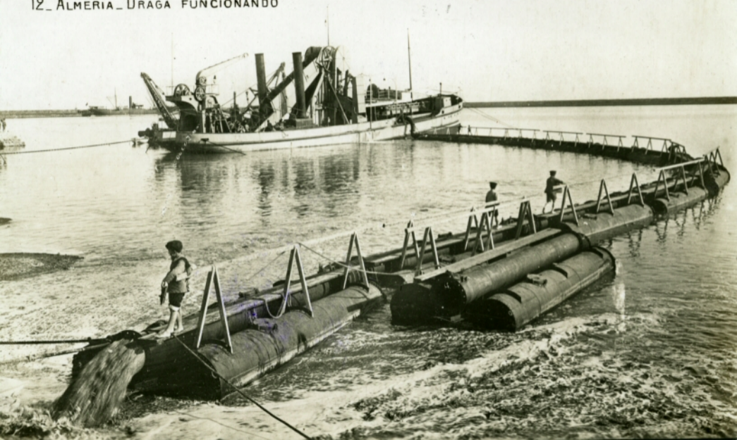
12_ ALMERIA_ DRAGA FUNCIONANDO
