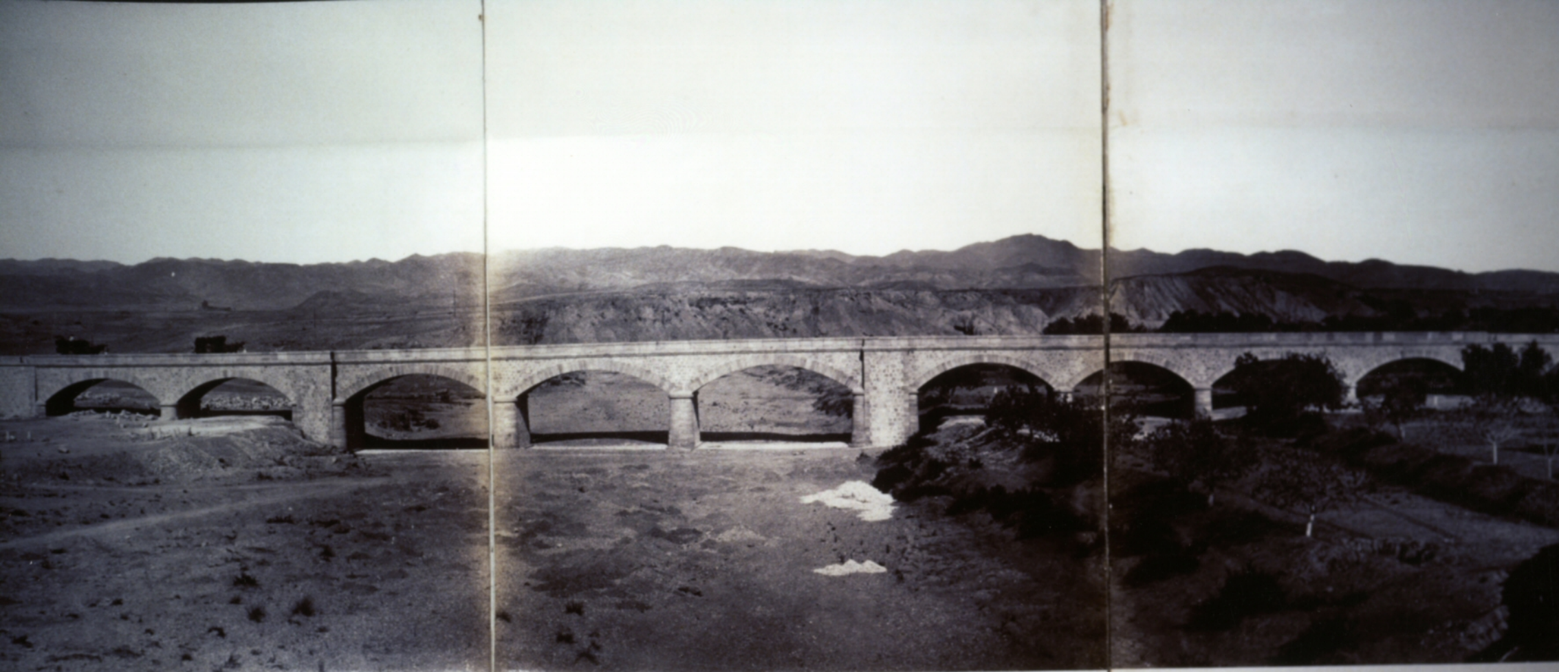
de Puerto de Lumbrales a Almorcia - Puente sobre la rambla de Antas
