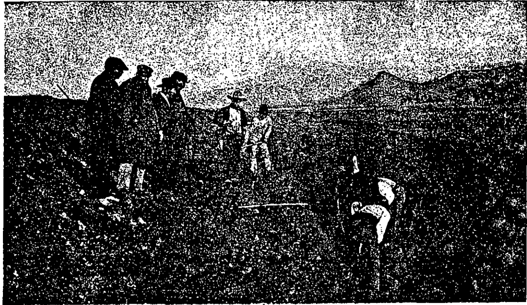
TRABAJOS DE CONSTRUCCIÓN DEL RAMAL DE GERGAL
