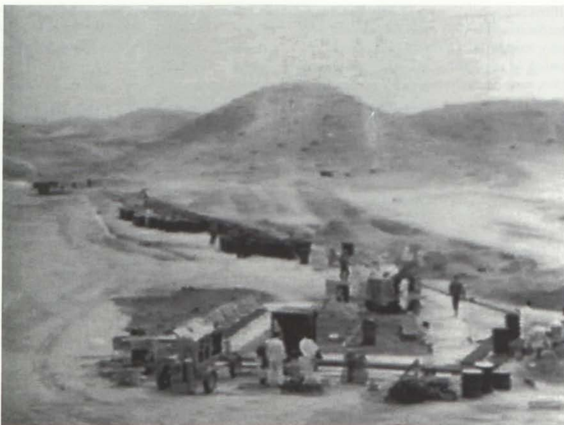
9. Monitoreo de barriles: Después de llenar los barriles y reforzar su cierre con flejes soldados, se controló su contaminación en 72 puntos aproximadamente. En las tapas superior e inferior, 12 en cada una, y 48 comprobaciones en los laterales. A pocos metros detrás se aprecia el terreno roturado una vez cegadas las fosas-trincheras. (Taschner Report)
